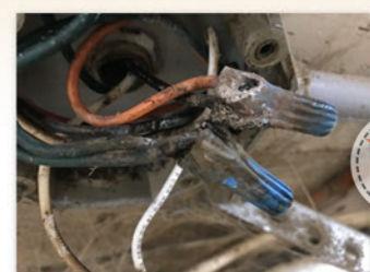
Boîte de jonction ayant perdu son étanchéité et circuit en défaut.
